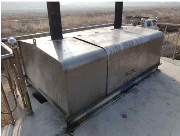
권양기 상태 양호
