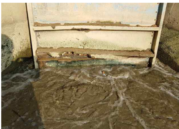
Flab문짝 보강재 파손
